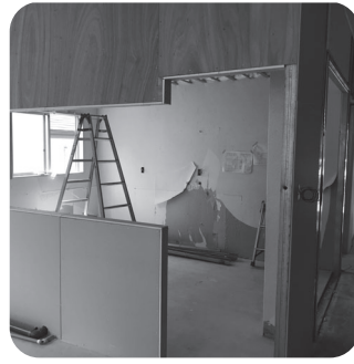
新事業所内装工事の様子
