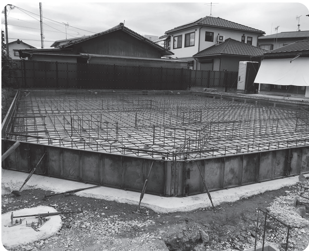
建て替えの基礎工事まで進んだ水巻第3あかとんぼ
